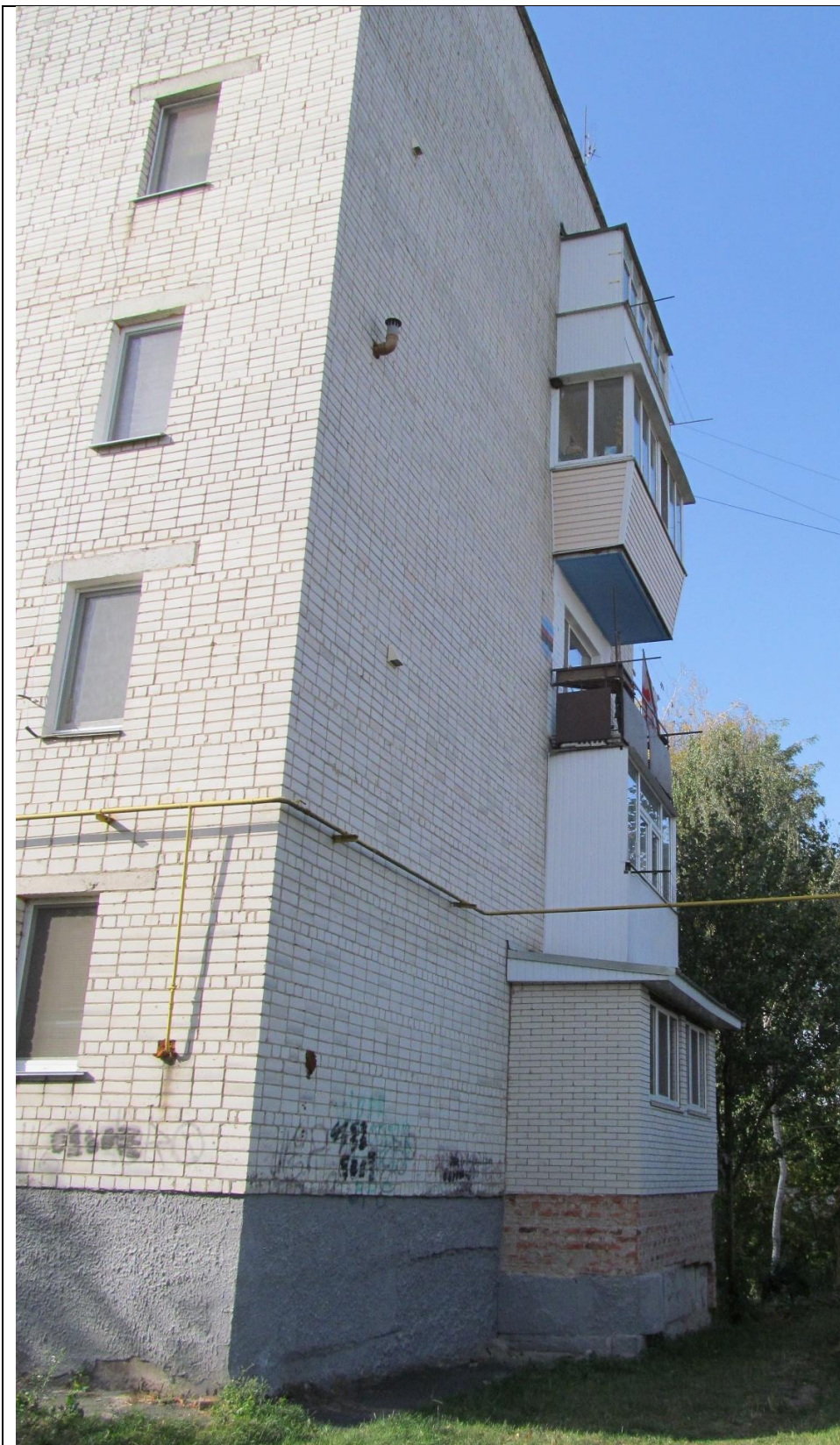
Прибудова, газова труба, димар газового теплогенератора, який є джерелом індивідуальної системи опалення.
