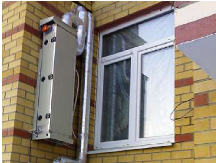
Світлина 3. Рекупераційна установка на фасадній стіні будівлі
