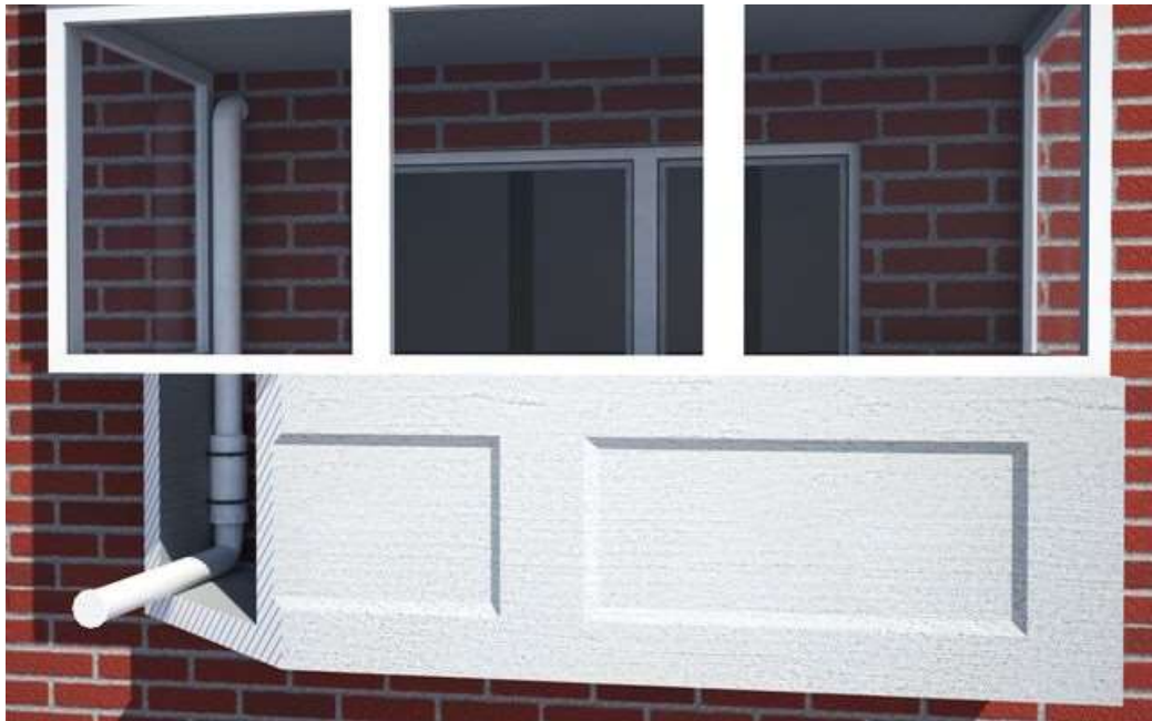
Світлина 5. Загальний вигляд повітропроводу при встановленні рекупераційної установки в приміщенні
